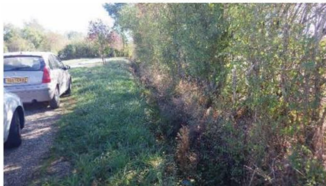
Photo 2 : Fossé d'évacuation pour le nouveau lotissement
