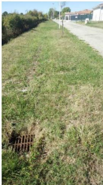
Photo 4 : Noue existante avec regard
